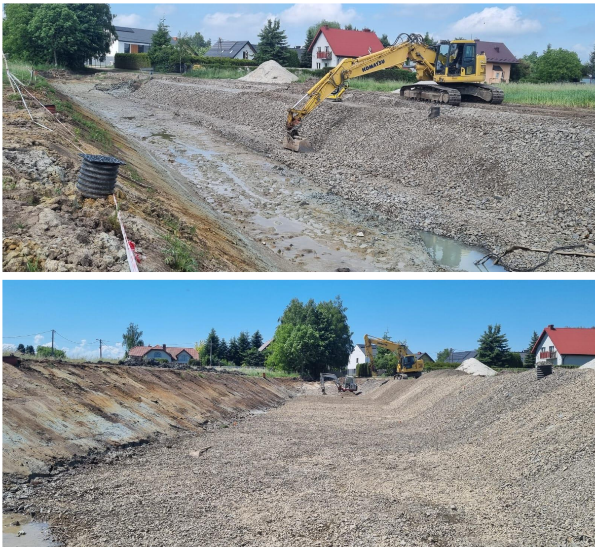
Rys. 16. Zakres wymiany gruntu w strefie osuwiska skarpy
